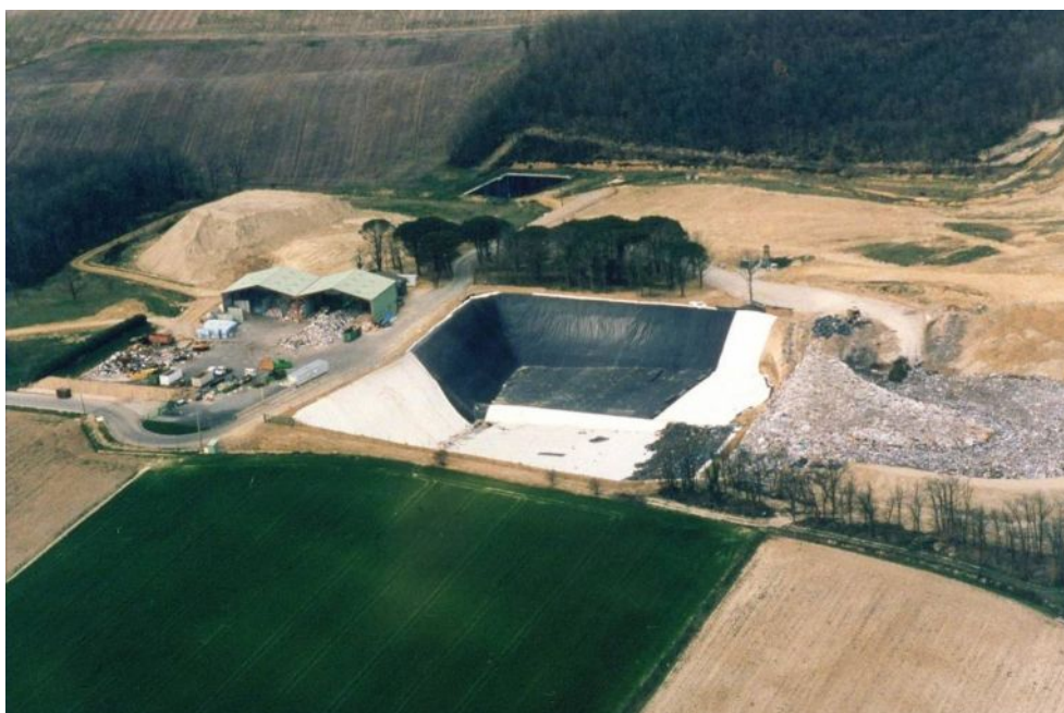
Casier de stockage des ordures Ménagères dans un Centre d'Enfouissement Technique de Classe II
